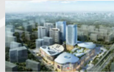
Grandes almacenes Wangfujing, ciudad de Foshan, provincia de Guangdong
